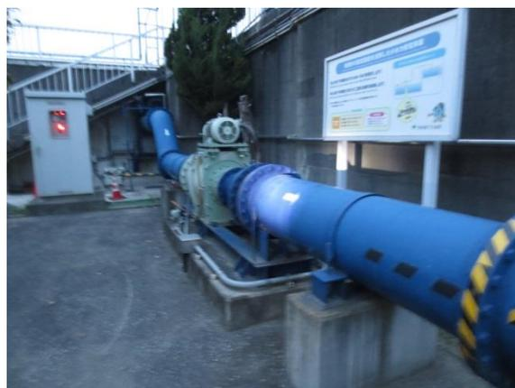
水再生センター西施設では放流落差を利用して小水力発電も行っています
