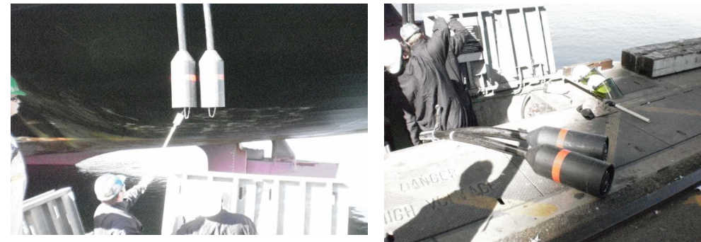
ロサンゼルス港における陸上電力供給の実施状況
